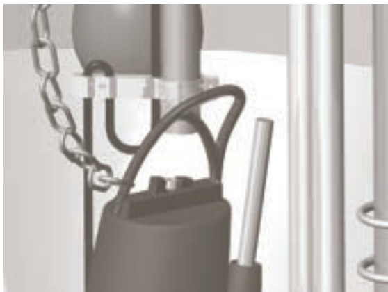
Fig. Kæde fastgjort på pumpen
