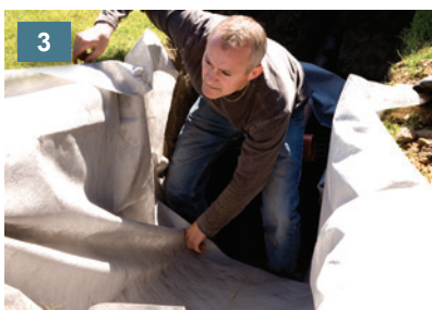
3: Fiberdugen lægges ud i bunden af udgravningen på underlag og perforeres i bunden. Placer BIO-BLOK® elementerne med lodret stående rør. Undgå så vidt muligt jord m.m. på duget.
