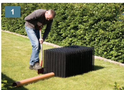
1: Placer BIO-BLOK® elementerne på jorden. Afmærk og udgrav til tilløb og faskine. Husk, at frostsikring for tilløbet er 75 cm. Udgrav 10 – 15 cm mere langs alle sider, end faskinen fylder.
