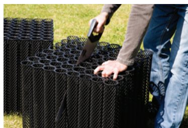
1: Placer BIO-BLOK® elementerne på jorden. Afmærk og udgrav til tilløb og faskine. Husk, at frostsikring for tilløbet er 75 cm. Udgrav 10 – 15 cm mere langs alle sider, end faskinen fylder.
