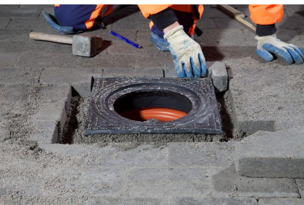
Stenene skæres til og lægges i grus.
